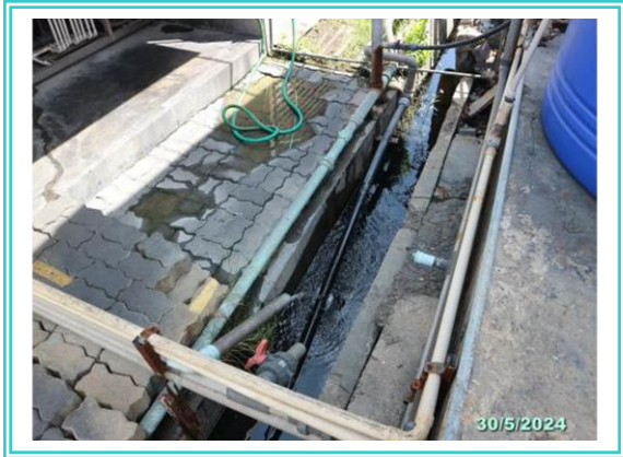
รูปที่ 3-7 รางระบายน้ำทิ้งจากหอหล่อเย็น
