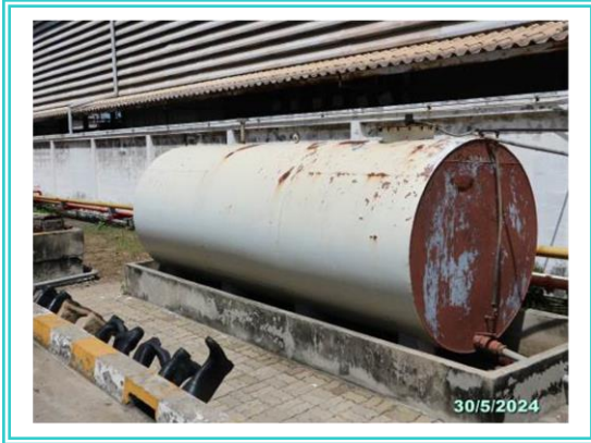
รูปที่ 3-1 ถังรวบรวมน้ำเสียจากการผลิต รองส่งกำจัด
